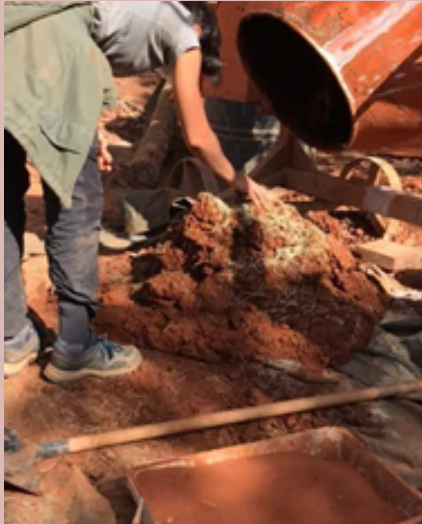
Feitio do reboco grosso.
